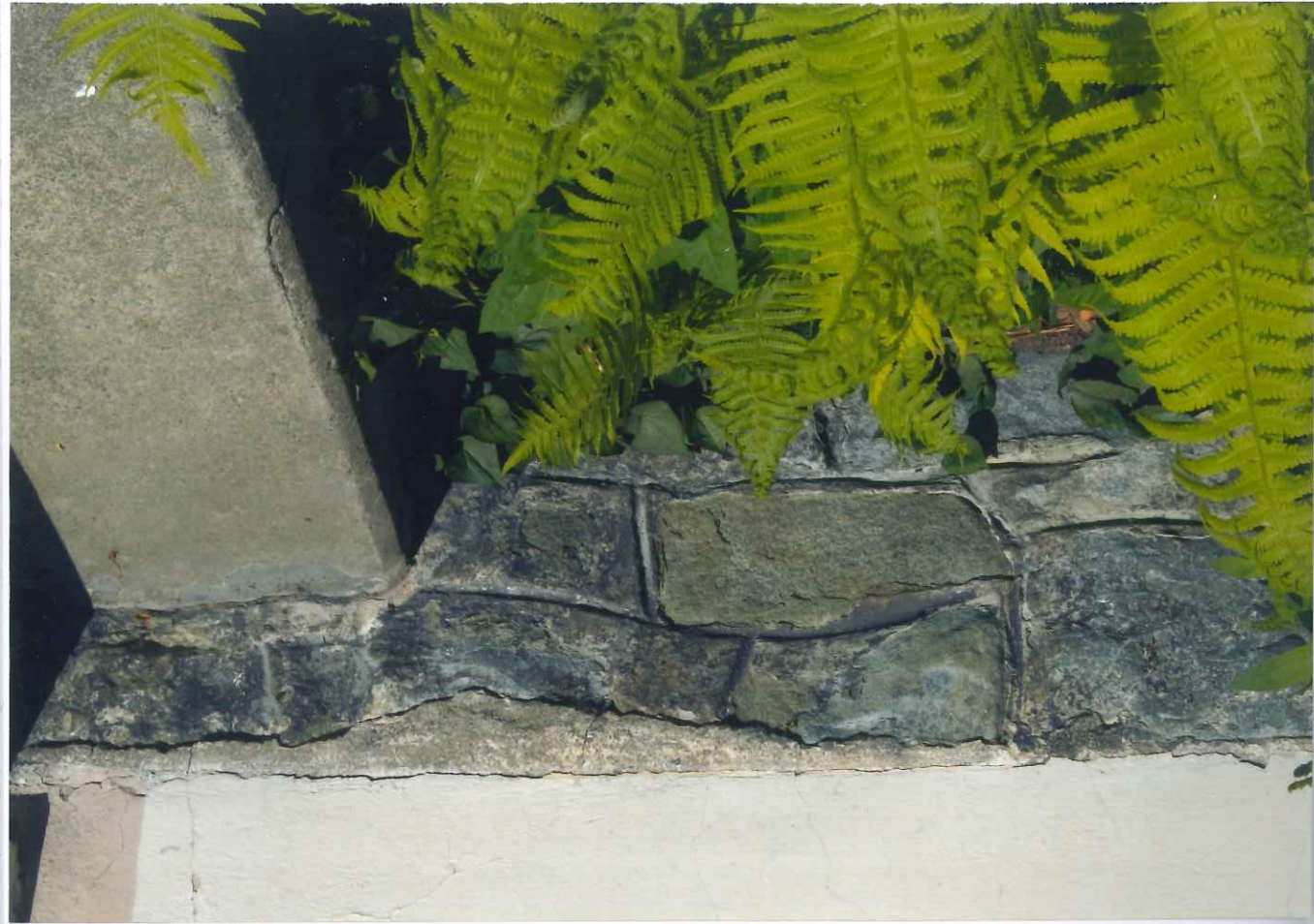
Fot. 10 - Muzeum Historyczne w Bielsku-Białej. Willa Juliana Fałata. Elewacja południowa - betonowe schody i fragment współczesnej nawierzchni z kostki betonowej oraz fragment kamiennego cokołu. Fot. Jan Gałaszek, maj 2020 r.
