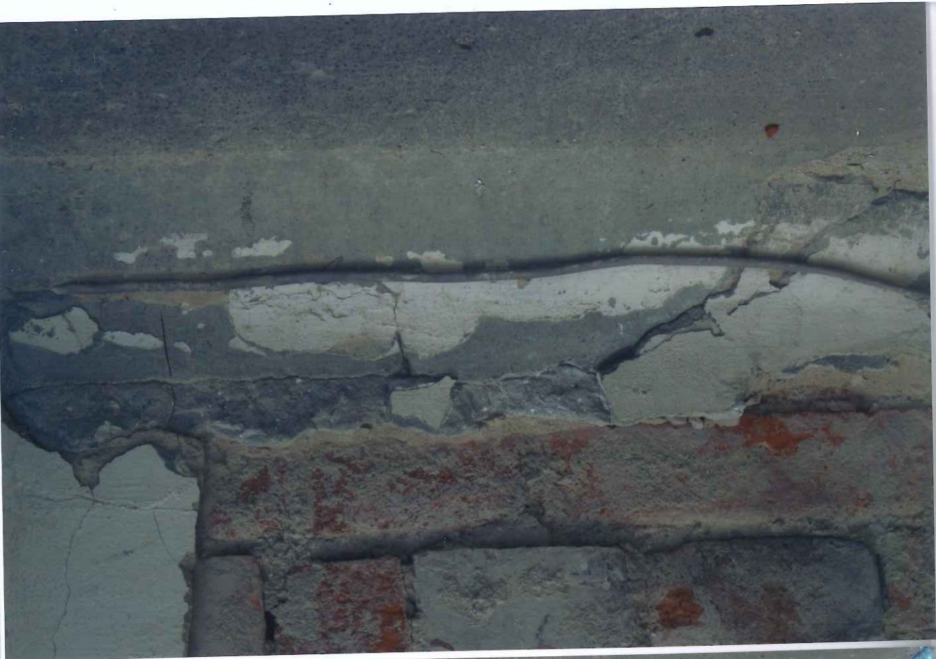
Fot. 12 - Muzeum Historyczne w Bielsku-Białej, Willa Juliana Fatata. Ściana wschodnia wneki drzwi - dobry stan zachowania muru ceglanego natomiast bardzo zły stan tynków; na pozostałościach starszych tynków wapiennych nałożone są warstwy tynków i gładzi cementowych oraz farb tzw. emulsyjnych.
