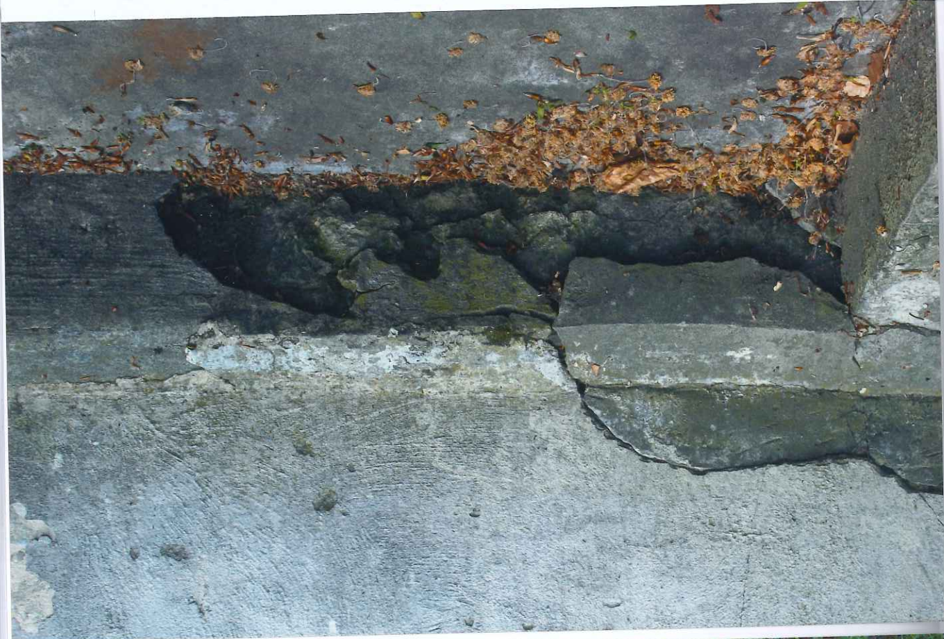
Fot. 15 - Muzeum Historyczne w Bielsku-Białej, Willa Juliana Fatata. Stan zachowania betonowego cokotu; twarda i szelna warstwa betonu położona na murowane również jest przez betonową opaskę biegnącą wokół murów.
