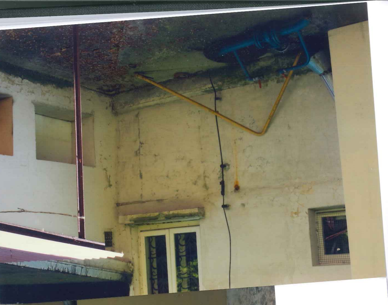
Fot. 34 - Muzeum Historyczne w Bielsku-Białej. Willa Juliana Fałata. Fragment elewacji od strony wschodniej budynku; pokryte farbą „emulsyjną” tynki współczesne oraz nowa stolarka okienna. Fot. Jan Gataszek, maj 2020 r.
